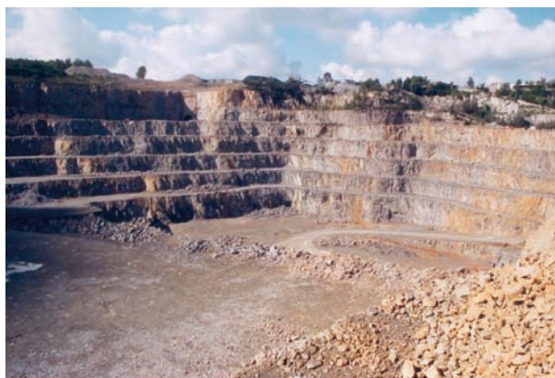
Une fosse d'extraction avec ses gradins. Les véhicules circulent sur les pistes que ces gradins constituent.
